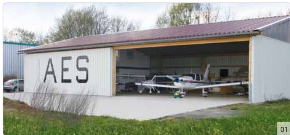
01 Die ungedämmte Flugzeughalle bietet durch die freitragende Holzkonstruktion und die zwei 12 m großen Toreinfahrten optimalen Raum für die sichere und funktionale Unterbringung von Privatflugzeugen.
