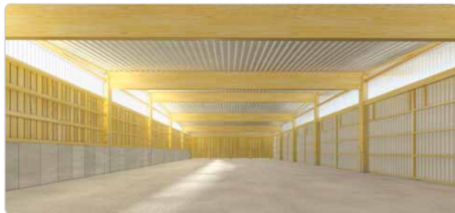
Durch die großen GROHA -Lichtgiebel wird Ihre VARIKO -Halle optimal ausgeleuchtet. Die Verwendung von Stahltrapezprofilen zur Dacheindeckung mit hellen Unterseiten verstärkt das freundliche und saubere Raumgefühl zusätzlich.
