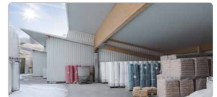
Drei halbgeschlossene Überdachungen mit großem Dachüberstand schützen das untergestellte Lagergut besonders kostengünstig.
