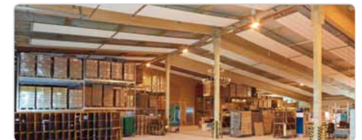
Diese gedämmte Logistikhalle mit angebautem Bürotrakt eines Herstellers von Verbrauchsmaterial überzeugt durch ein wohnliches Raumklima.
