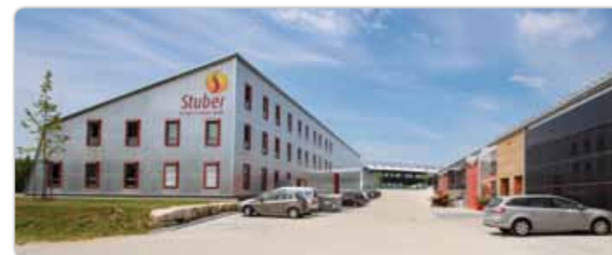
Die modernen Gewerbehallen eines Solarbetriebs fassen einen dreistöckigen Bürotrakt, Werkstatt, Lager und Verkauf. Sie sind großflächig mit Photovoltaik belegt und bestehen teilweise aus gedämmten Lichtbauelementen.
