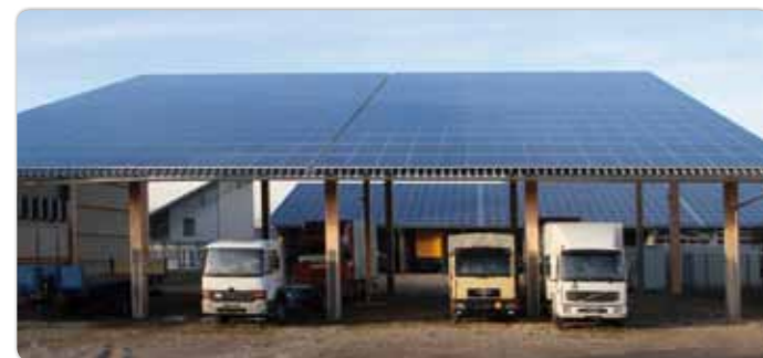
Dieser LKW-Port mit großflächiger Solaranlage erlaubt es beidseitig ein- und auszufahren.
